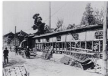
昭和20年 大正町・岡空酒造の被害
